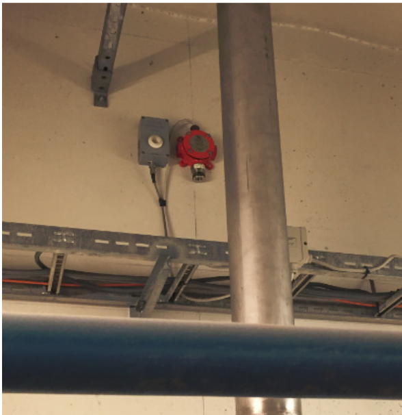
Figur 2 - Gassdetektorer under tak i fyrrom
